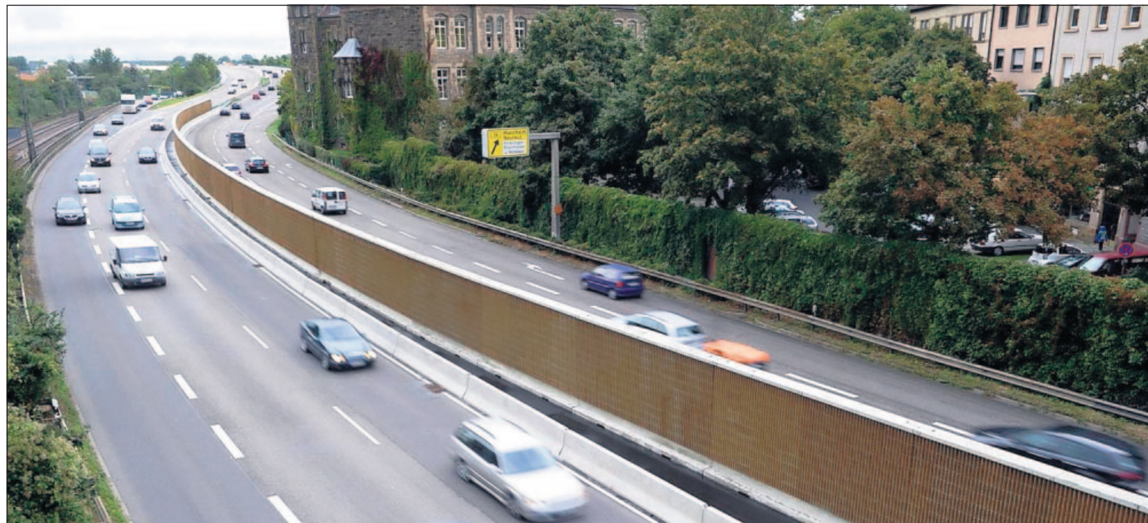
Zwischen den beiden Fahrbahnen liegt die neue Lärmschutzwand an der Südtangente auf der Höhe des Stadtteils Mühlburg: Der Grund liegt im Material: Der Werkstoff „Holzbeton“ der Mauer, eine Kombination aus Zement und Holzfasern, gilt als besonders lärmschluckend. FOTO: ARTIS
